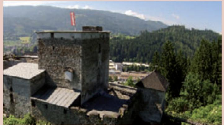
bereich und die Decke erneuert. Aber der Zahn der Zeit nagte weiter und zwar an der Außenmauer des Bauwerkes. Um der drohenden Einsturzgefahr des südlichen Rundturmes entgegenzuwirken, wurden die bis zu ein Meter dicken Mauern saniert. Löcher mit einem Durchmesser von bis zu einem Meter wurden mit den ursprünglichen Steinen ausgemauert und verworfen. Auch so manche Gefahrenquelle im Bereich des Zwingers (freier, begehbare Raum zwischen Ringmauer und Burggebäude) wurde eingedämmt.
