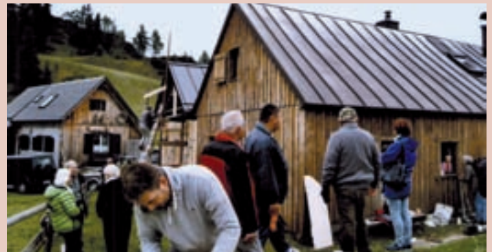
Instandsetzungsarbeiten bei der Grashütte
