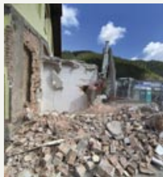
Abbruch von massiven und schweren Bestandsfundamentkonstruktionen
