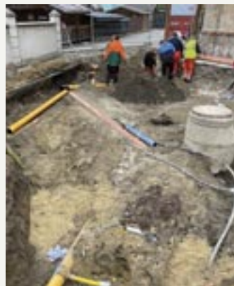
Umleitung der in das Bestandsfundament integrierten Hauptgasleitung
