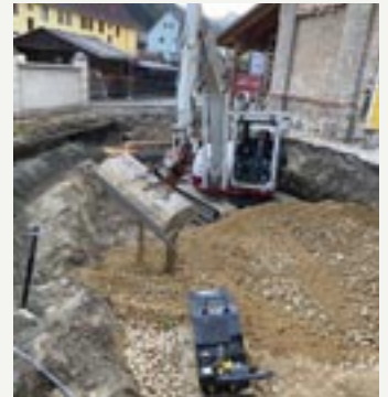
Großflächige Bodenaustauscharbeiten bis in eine Tiefe von 2,3 m
