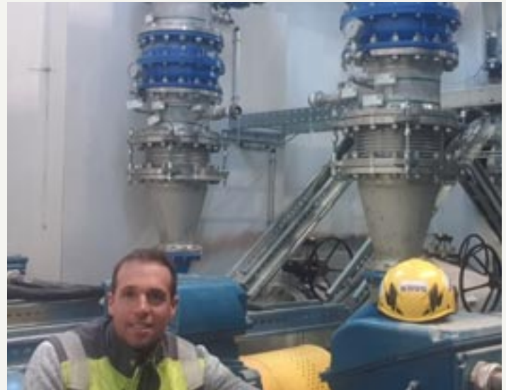
Rückkühlanlage eines Stahlwerkes
